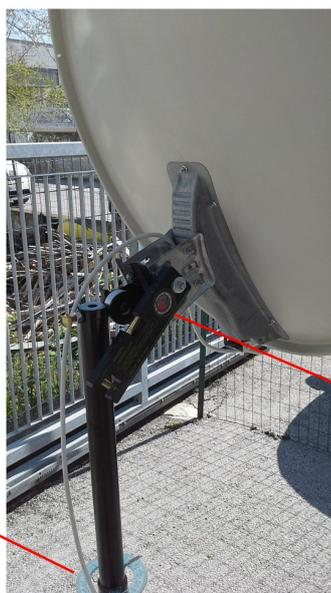
Movimento in elevazione dell'antenna con inclinometro a bolla.
