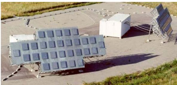
**Figura 3:** Due delle quattro antenne a pannello del trasmettitore radar *GRAVES* operante a 143.050 MHz (Observatoire de Paris, Division Surveillance Espace).
